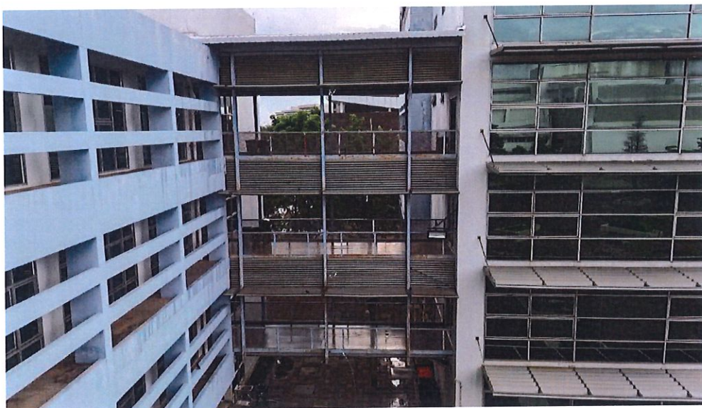
ทางเชื่อม อาคาร SCB2-3
