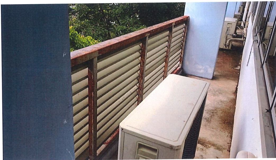
ทาสีเหล็กรั้วแผงอลูมิเนียมกันสาด
